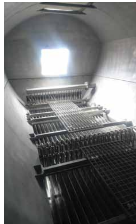
Рис. 2. Вид внутренней части охладителя с кипящим слоем с пластинчатым теплообменником
